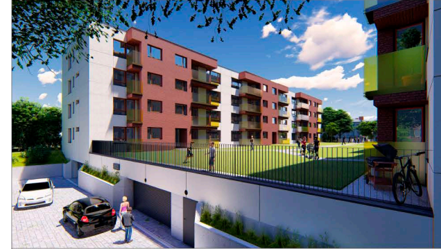
LOKALIZACJA W BUDYNKU
