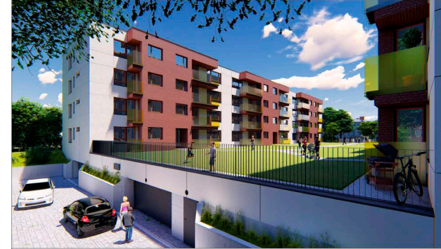
LOKALIZACJA W BUDYNKU
